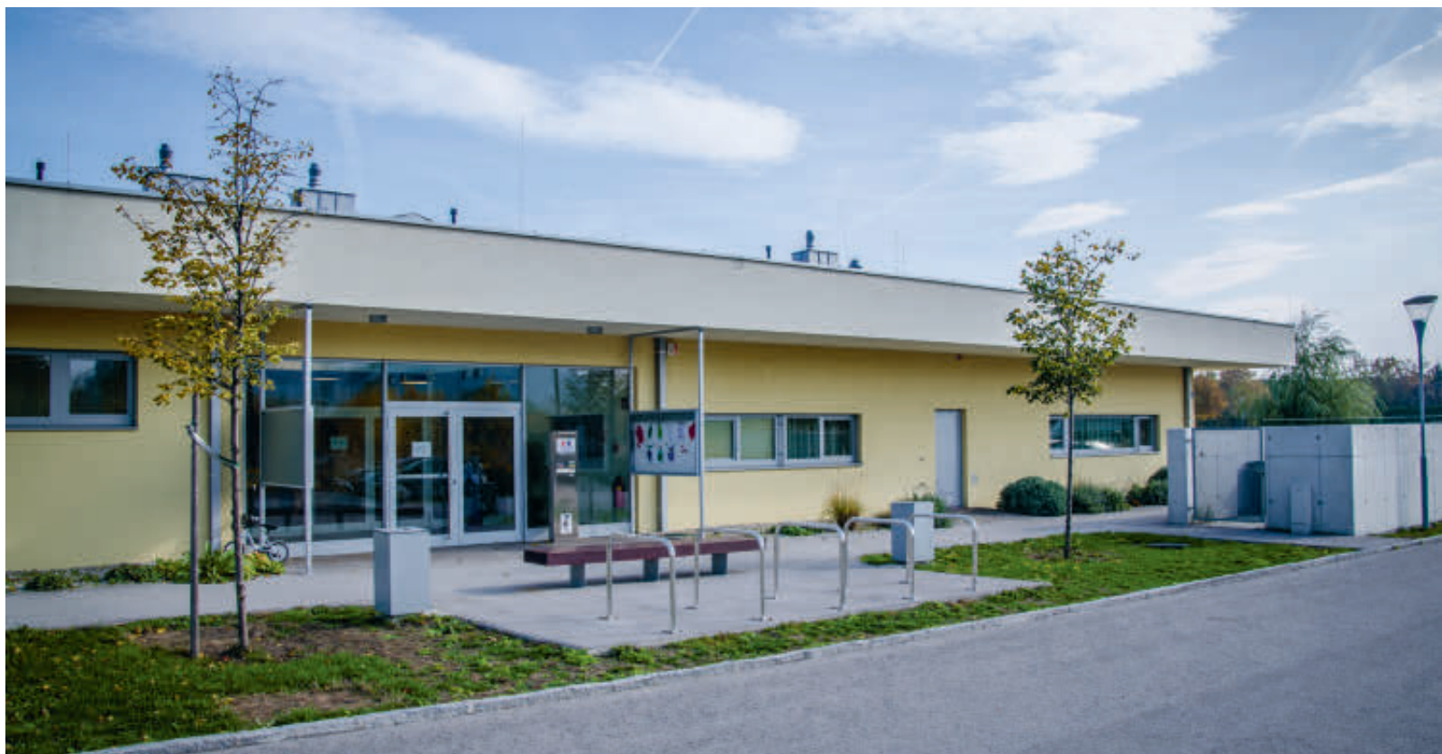
Der Kindergarten am Sonnenblumenweg wurde vor zehn Jahren errichtet - nun erhält er einen dringend benötigten Zubau. (Foto: S. Ebster)
