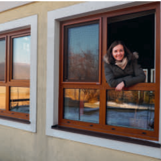
← Die neuen Fenster im Kindergarten Großau sorgen u.a. für bessere Wärmedämmung. (Foto: SGBV)
