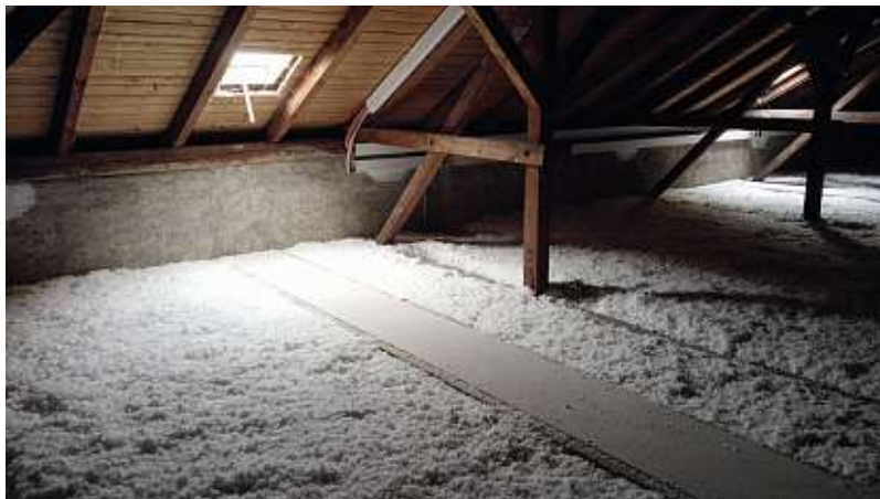
Die Sportmittelschule ist bereits das sechste Gebäude, wo Dämmmaßnahmen in der obersten Geschoßdecke umgesetzt wurde. (Foto: Stadtgemeinde Bad Vöslau)
