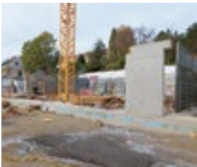
Oktober 2022 Betonbauarbeiten für den Neubau beginnen.
