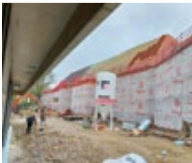
April 2023 Neues Dach, neue Fassade.
