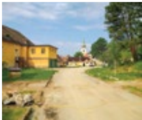
Mai 2022 Die ersten Abbrucharbeiten beginnen.
