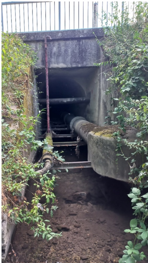
Abbildung 6: Durchlass Bahn zwischen Castelligasse und Bahnzeile mit bestehender Verrohrungen
